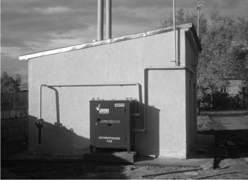
Գազահաշվիչային հանգույցով պահարանային գազակարգավորիչ կետը
