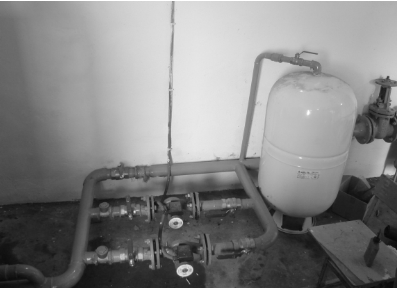
Կաթսայատանը տեղակայված շրջանառու պոմպերը և մեմբրանային ընդարձակման անոթը
