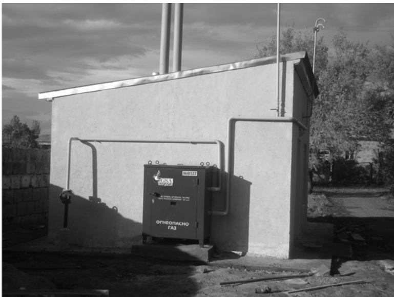
Գազահաշվիչային հանգույցով պահարանային գազակարգավորիչ կետը
