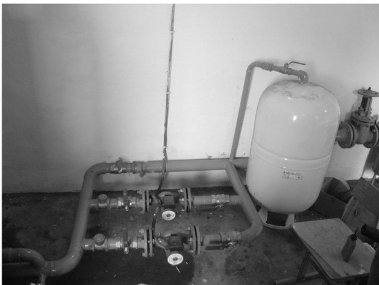
Կաթսայատանը տեղակայված շրջանառու պոմպերը և մեմբրանային ընդարձակաման անոթը
